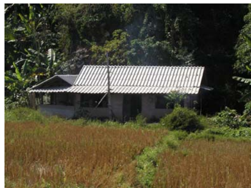
OPC's nur teilweise fertiggestellte Schule
