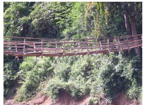
eine Brücke aus Bambusstecken
