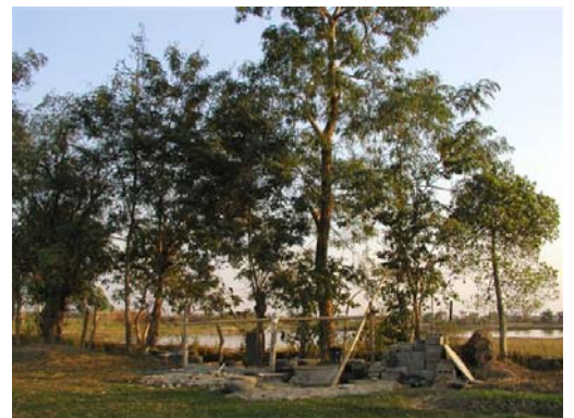
Ort, wo die Wasseranlage gebaut wird
