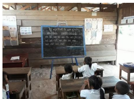
Schulkinder im Unterricht in einem der zerfallenden Klassenzimmer.
