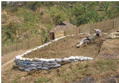
Das Land wird für den Bau vorbereitet
