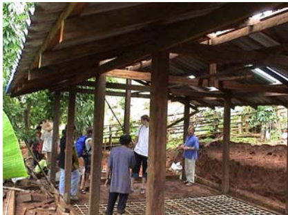
Im Bau stehende Schule im Tomaten Dorf
